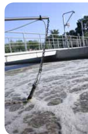
Abb. 6: Die Sensor-montage an einer Kette ermöglicht die Bewegung des Sensors zur Selbstreinigung. Eine Druckluftreinigung kann bei Bedarf nachgerüstet werden.
